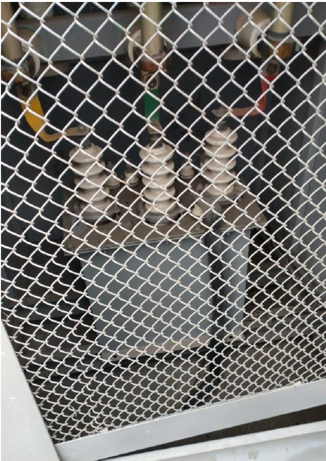
Фото до замены трансформаторов напряжения 10 кВ
