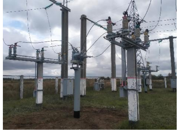
Фото после монтажа вакуумных выключателей 35 кВ
