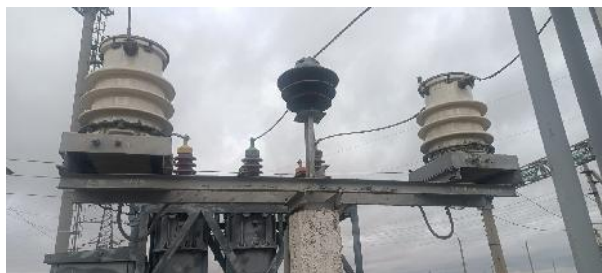
Фото до замены трансформаторов тока 35 кВ
