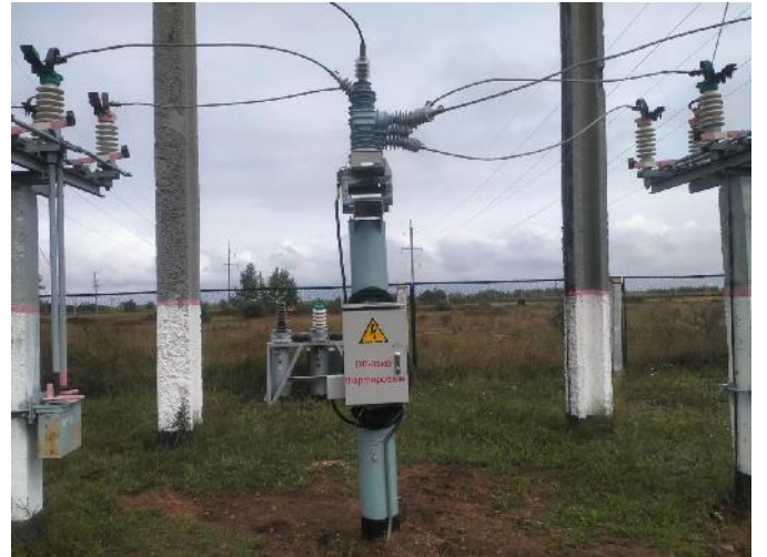
Фото после установки комплектного 2-х секционного открытого распределительного устройства 10 кВ на вакуумных реклоузерах 10 кВ
