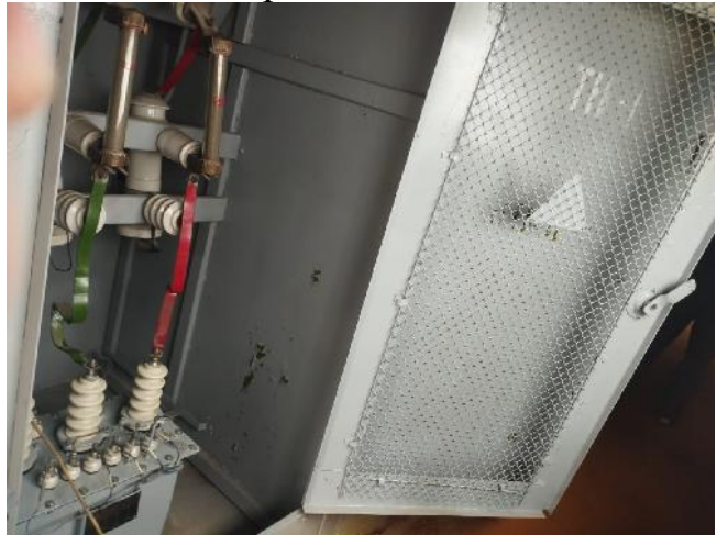
Фото после замены трансформаторов напряжения 10 кВ
