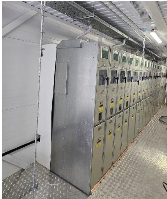
Фото после монтажа вакуумных выключателей 35 кВ
