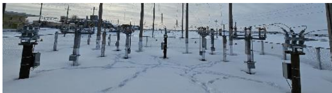
Фото после монтажа вакуумных выключателей 35 кВ
