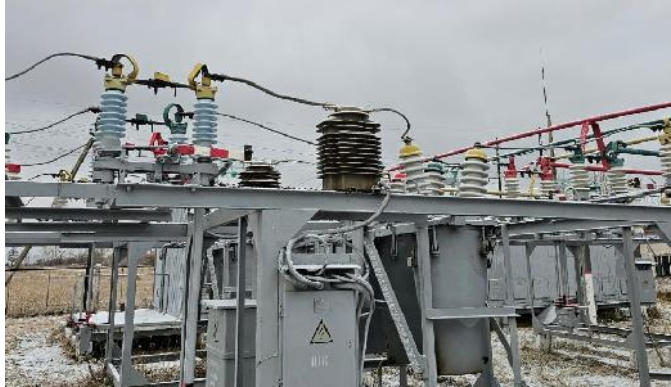
Фото после замены трансформаторов тока 35 кВ
