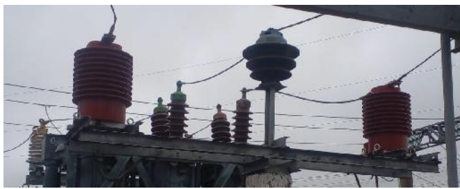
Фото после замены трансформаторов тока 35 кВ
