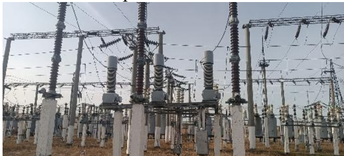
Фото после замены трансформаторов напряжения 110 кВ
