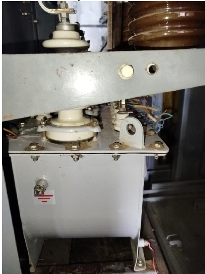
Фото после замены трансформаторов напряжения 10 кВ
