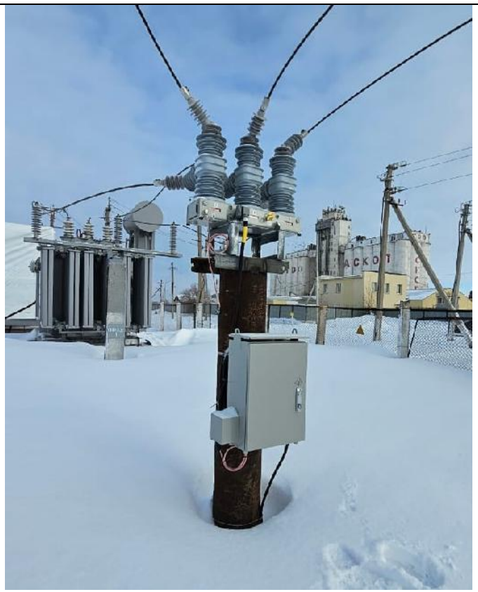
Фото после замены силового трансформатора
