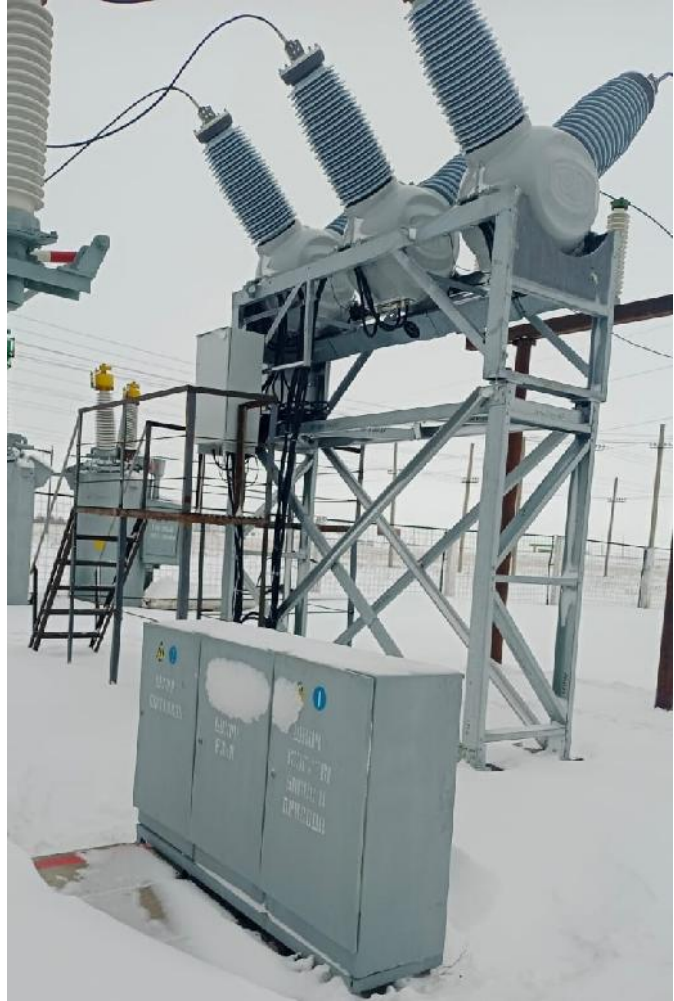
Фото после монтажа элегазового выключателя 110 кВ
