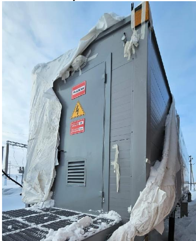
Фото после установки блочно-модульного здания
