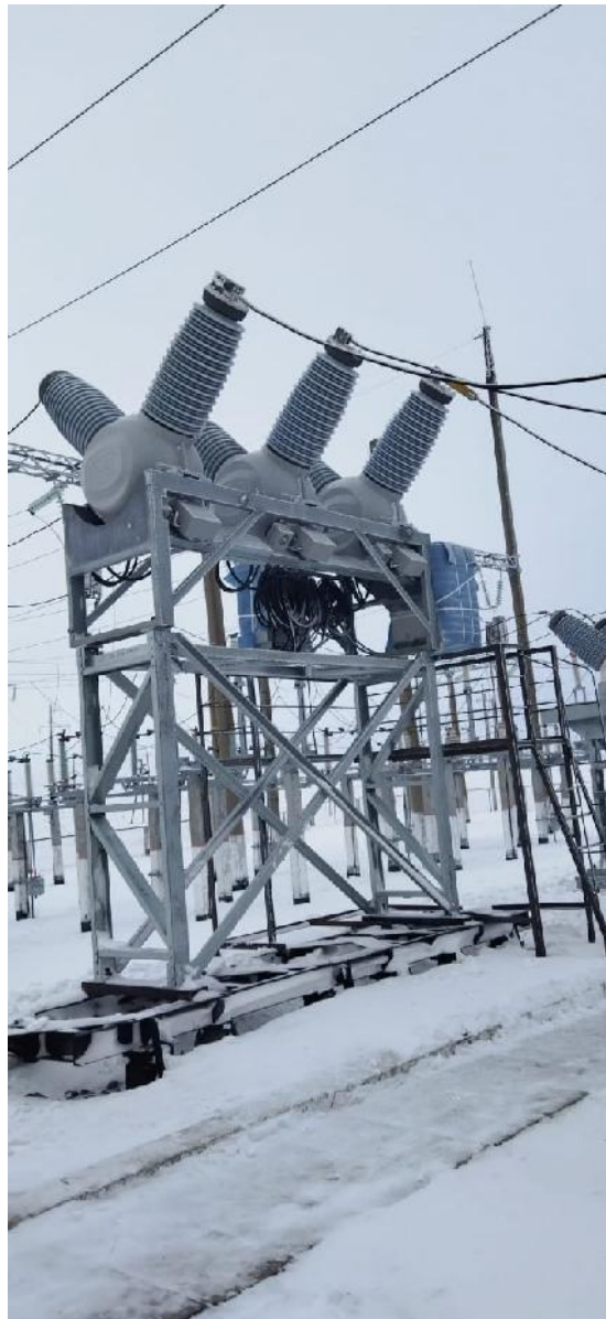
Фото после монтажа элегазового выключателя 110 кВ
