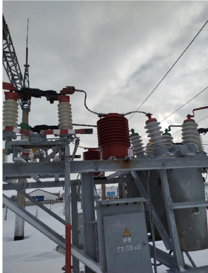
Фото после замены трансформаторов тока 35 кВ
