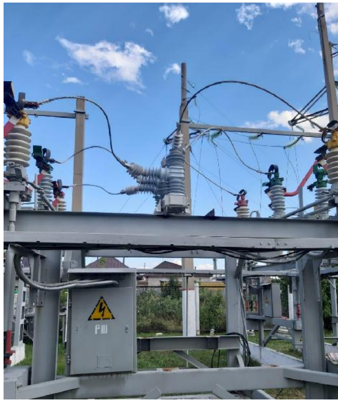
Фото после монтажа вакуумных выключателей 35 кВ
