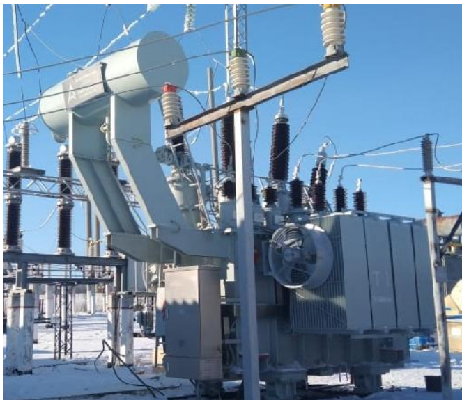
Фото после замены силовых трансформаторов
