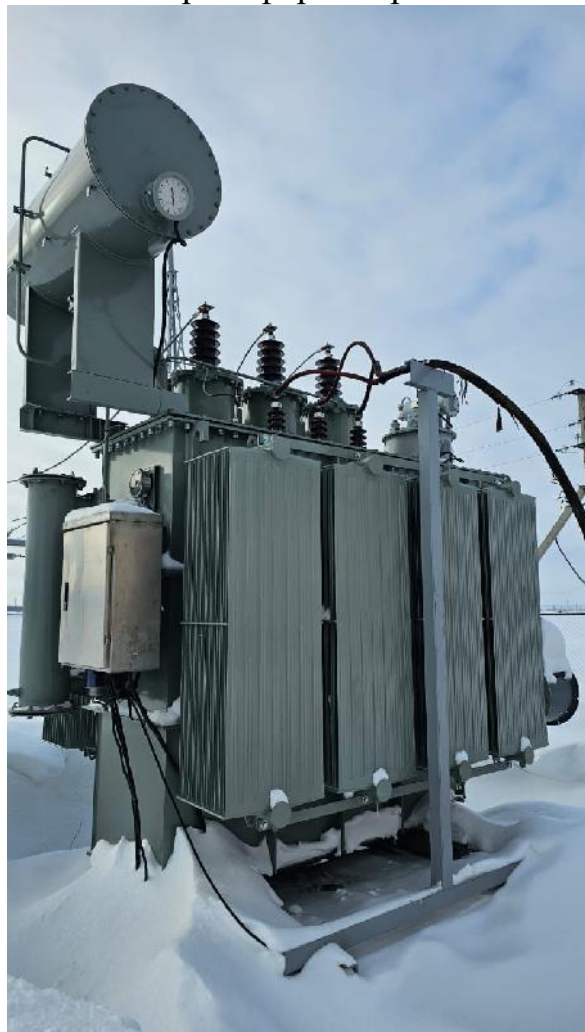
Фото после замены силового трансформатора
