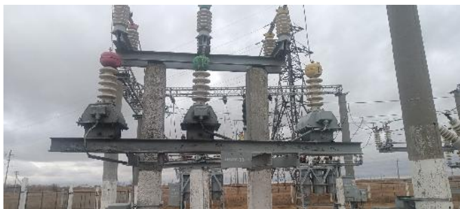
Фото до замены трансформаторов тока 35 кВ
