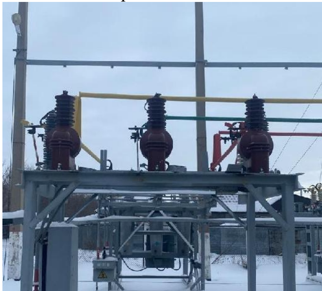
Фото после замены трансформаторов напряжения 35 кВ
