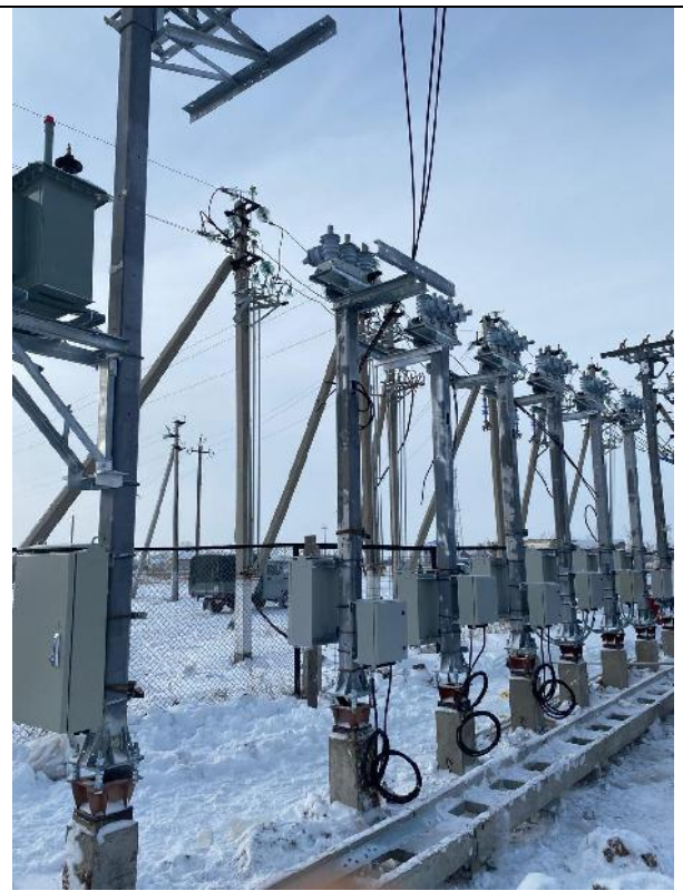
Фото после замены трансформаторов напряжения 10 кВ
