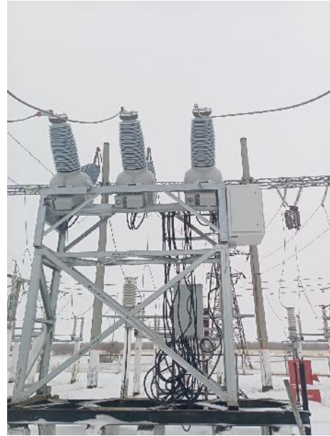
Фото после монтажа элегазовых выключателей 110 кВ
