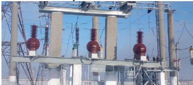
Фото после замены трансформаторов напряжения 35 кВ
