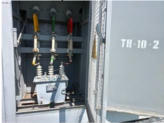
Фото после замены трансформаторов напряжения 10 кВ
