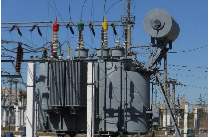
Фото до замены высоковольтных вводов силового трансформатора
