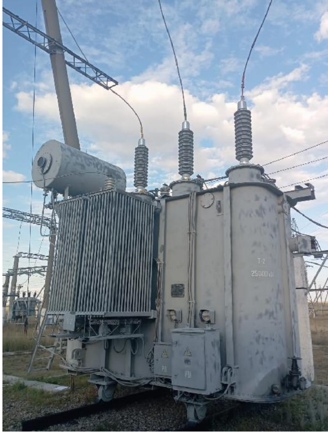
Фото после замены высоковольтных вводов силового трансформатора
