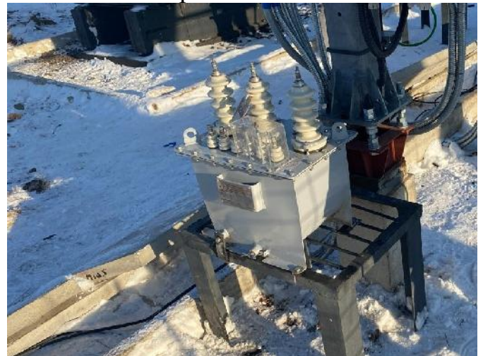
Фото после замены трансформаторов напряжения 10 кВ
