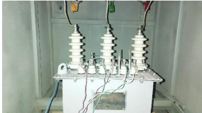
Фото после замены трансформаторов напряжения 10 кВ
