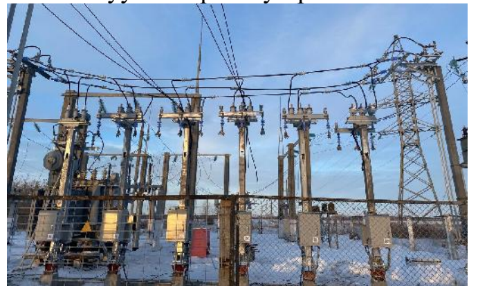
Фото после установки комплектного 2-х секционного открытого распределительного устройства 10 кВ на вакуумных реклоузерах 10 кВ
