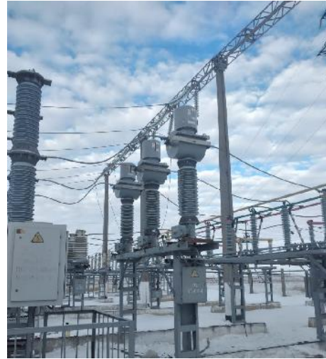
Фото после замены трансформаторов тока 110 кВ
