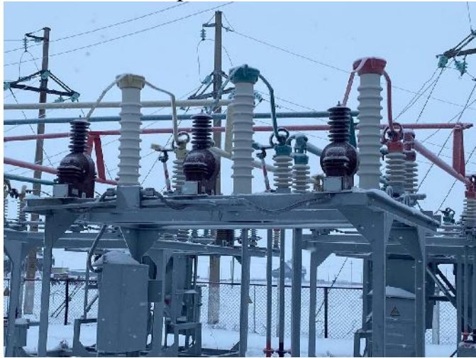
Фото после замены трансформаторов напряжения 35 кВ
