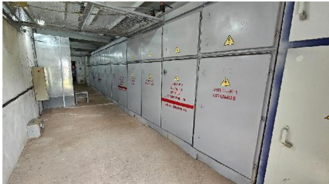
Фото до замены замена ячеек 10 кВ
